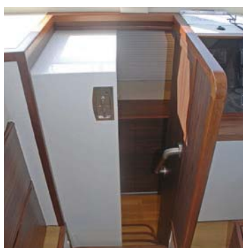
PUERTAS QUE NO OCUPAN ESPACIO La zona de noche de ambos cascos queda aislada del salón mediante puertas deslizantes.
