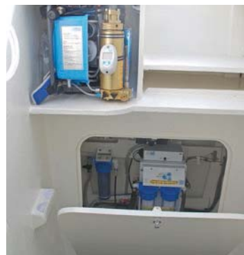
RINCONES APROVECHADOS Los escalones de bajada al pañol de proa del casco de babor esconden la potabilizadora y el compresor de aire.
